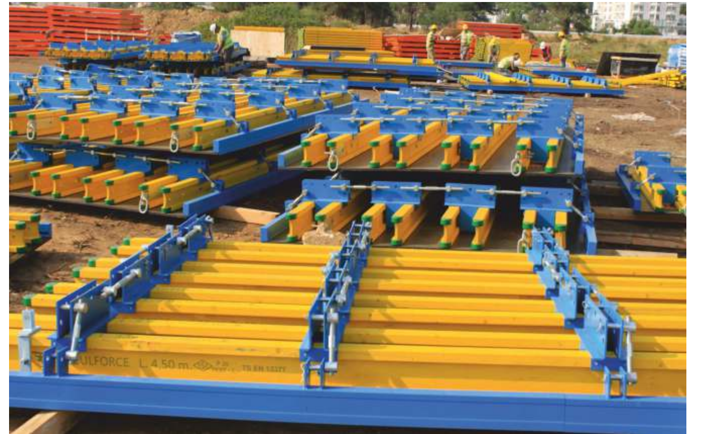
Adım 3 - Projeye göre şablon ile eğriselliğin verilmesi Step 3 - Forming the curve according to the formwork design
